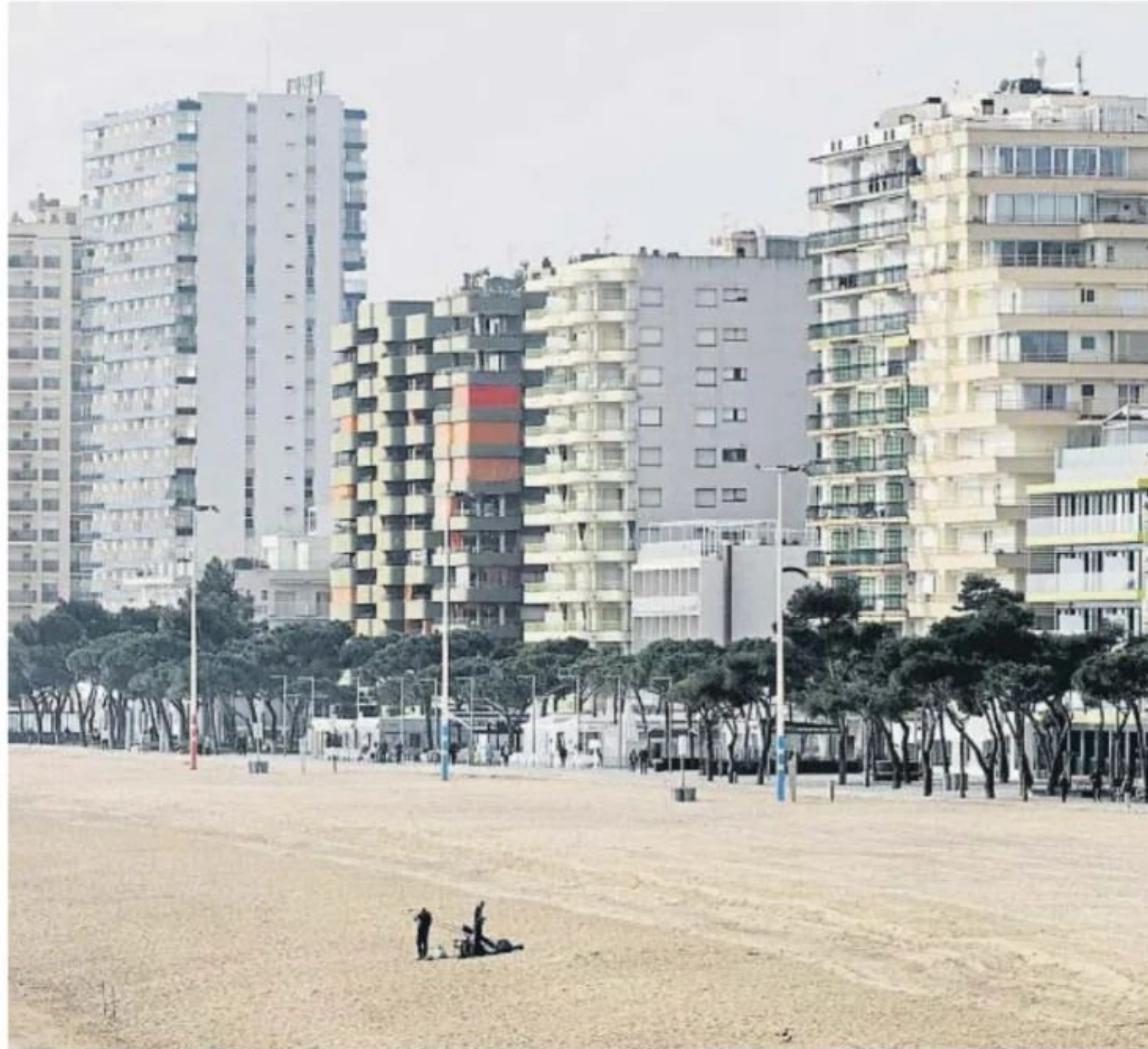
La situación afecta a 858 propiedades, entre pisos, garajes, casas o locales de primera línea de mar
